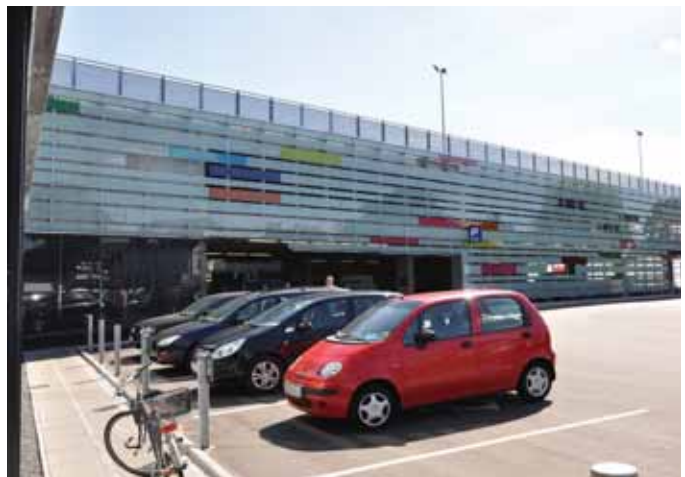
Parkhaus bei Einkaufszentrum
